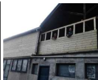
Rénovation de la maison des associations par Christophe, Benjamin et Denis
