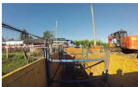
Réalisation d'un forage sous la voie ferrée pour desservir le quartier Batbielle en 2014 (photo Jean-Charles Roussel)
