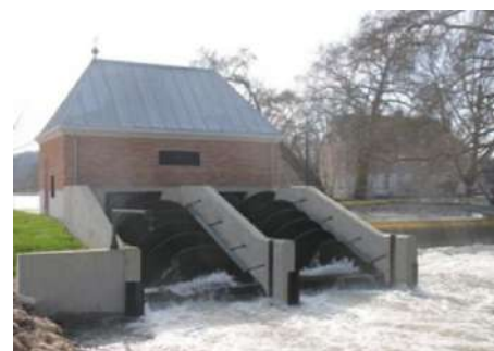
Un exemple de centrale hydroélectrique
